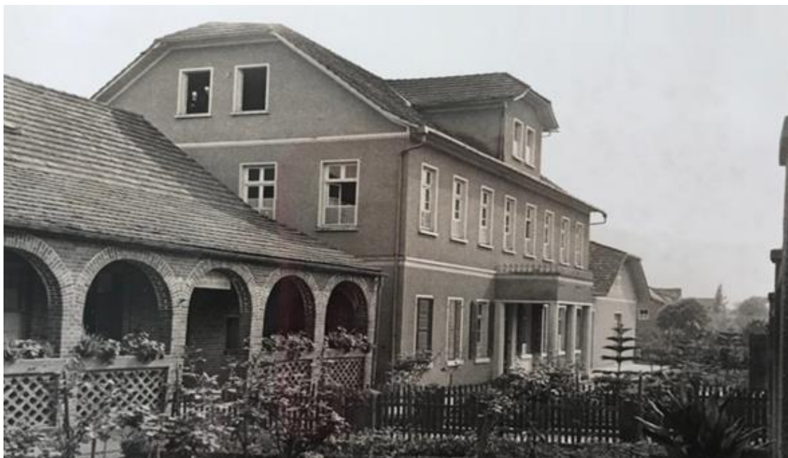
Antiga farmácia, moradia das Irmãs da Divina Providência e Capela.
