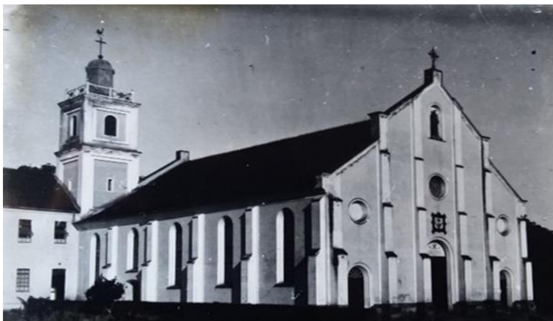
Inauguração da torre da Igreja Matriz (1902).
